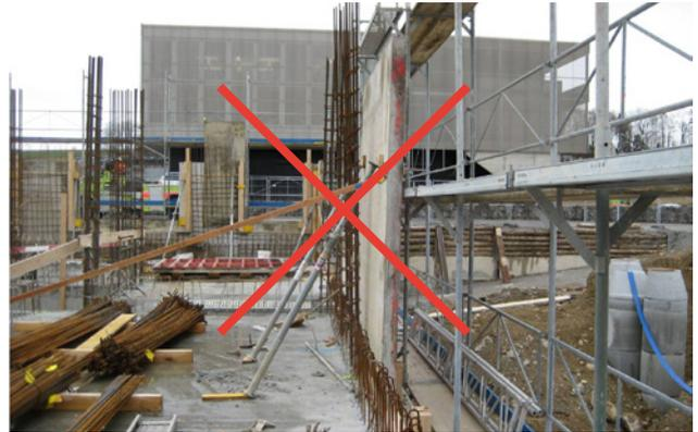
3 L'élément de coffrage n'est pas maintenu de façon à résister aux efforts de traction et de compression (étais pour dalles).
