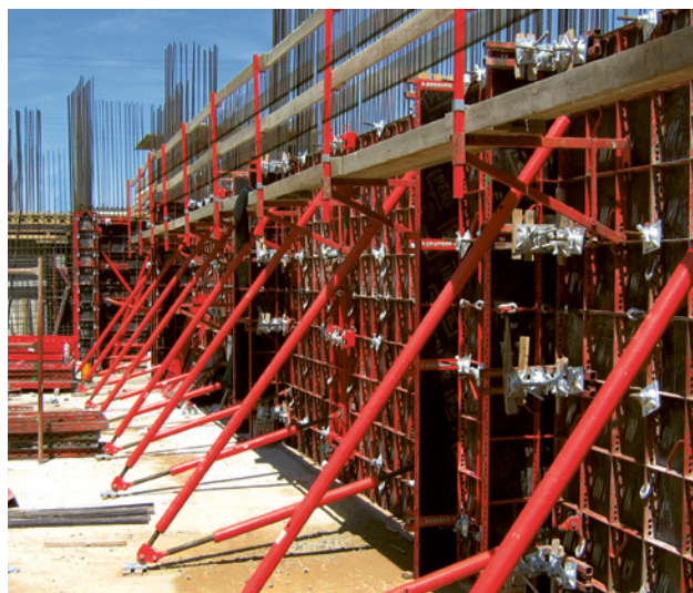
1 Coffrage de murs maintenu à sa tête et à sa base de façon à résister aux efforts de traction et de compression.
