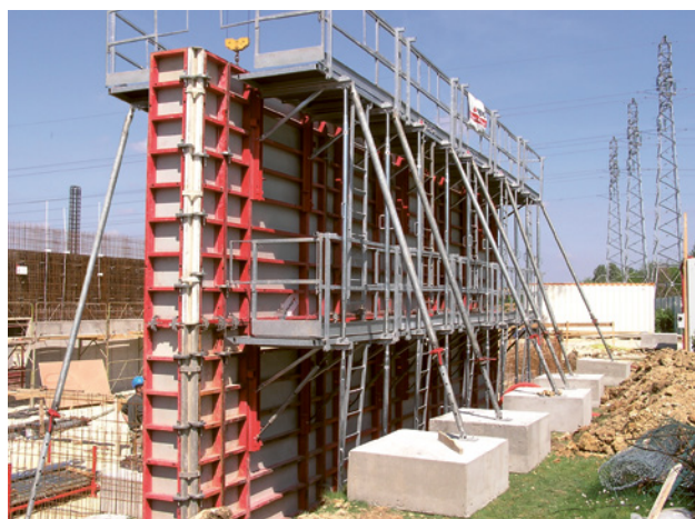
2 Ancrage de l'élément de coffrage vertical extérieur à l'aide de stabilisateurs sur des lests.
