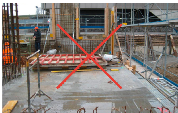
4 Accident: la victime a été écrasée par un élément de coffrage. L'étagage avec des étais pour dalles est à proscrire!
