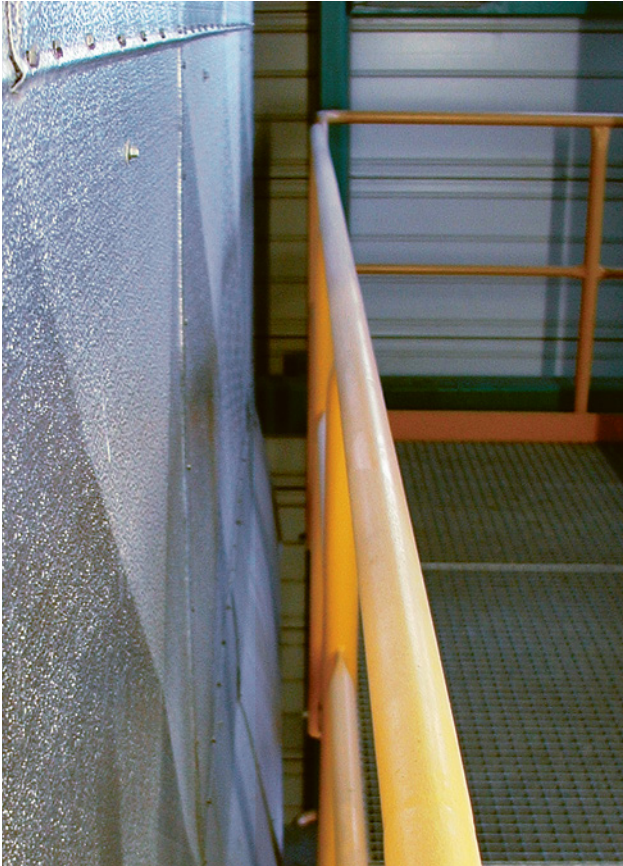
7 Geländer zur Sicherung der maschinen- bzw. wandseitigen Absturzkante. Das Geländer ist erforderlich, weil der Abstand der Lafebene zur seitlichen Maschinenverkleidung bzw. zur Wand mehr als 180 mm beträgt.
