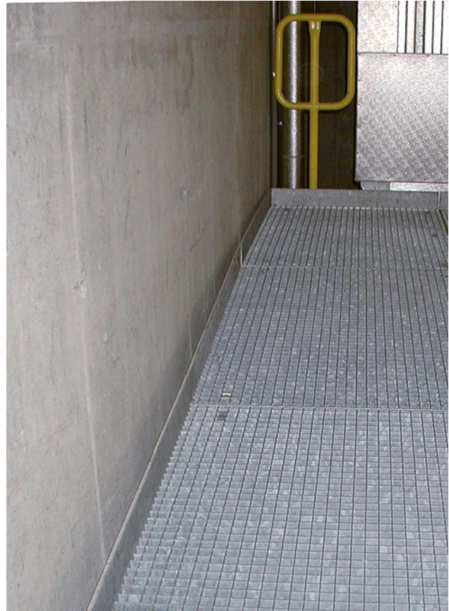
8 Fussleiste zur Sicherung der maschinen- bzw. wandseitigen Absturzkante. Die Fussleiste ist erforderlich, weil der horizontale Abstand der Lafebene zur Wand bzw. zur Maschinenverkleidung mehr als 20 mm beträgt. Im Bereich des Hintergrunds, wo der Abstand 180 mm überschreitet, wurde ein Geländersegment angebracht.
