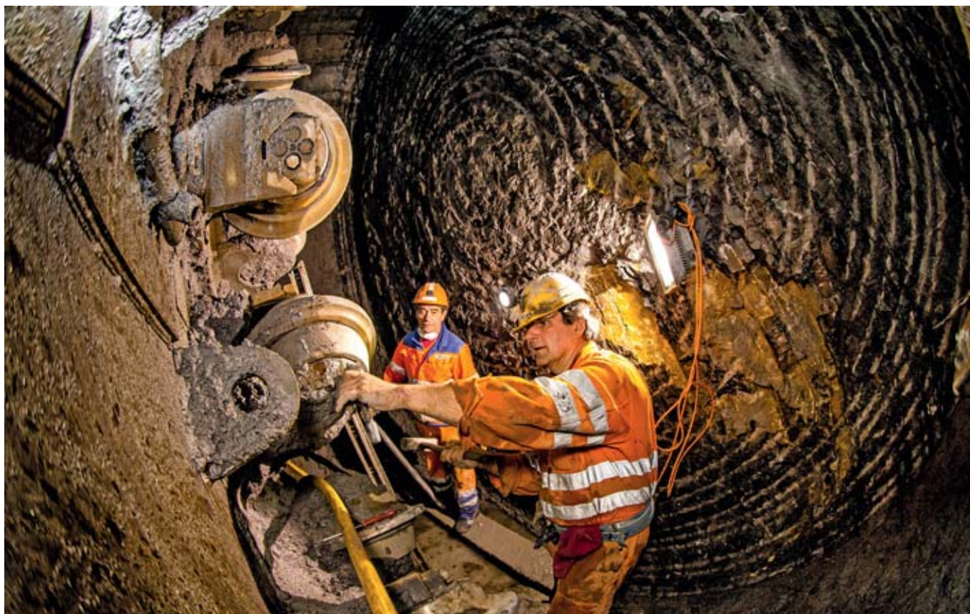
Travaux d'entretien sur la tête de forage du tunnelier à l'arrêt: les opérateurs se protègent en respectant les consignes de sécurité à la lettre.
