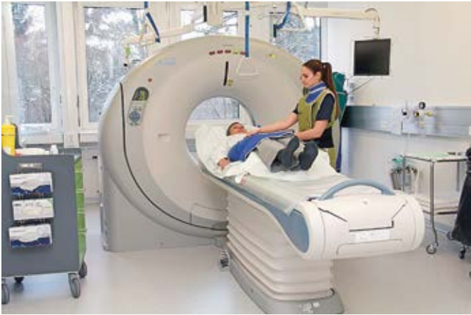
6 CT-Anlage in einem Spital
