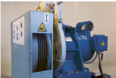
1 Treibscheibe mit Schutzhaube
