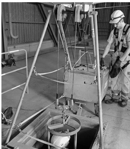
11 Siloeinstieg mittels Siloeinfahrgerät mit Arbeitskorb. Diese Einheit muss als Ganzes CE-konform sein.
