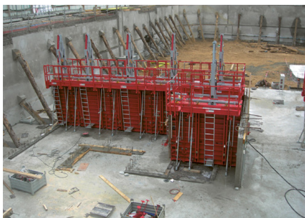
3 Coffrage de murs avec plateformes de bétonnage des deux côtés.
