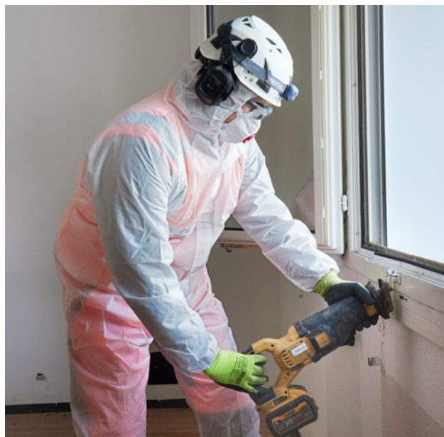
1 Découpage du cadre de la fenêtre à la scie égoïne
