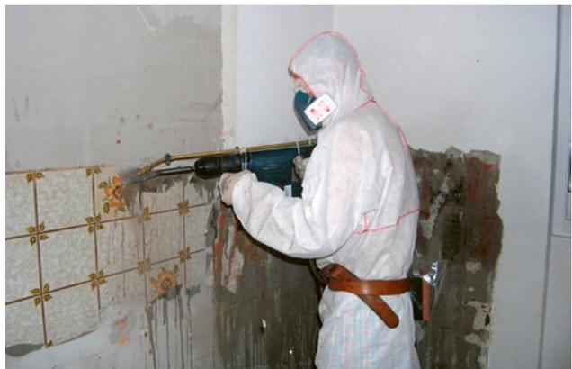
1 Les carreaux comportant de la colle amiantée doivent être enlevés par voie humide avec un perforateur équipé d'un dispositif de pulvérisation d'eau.
