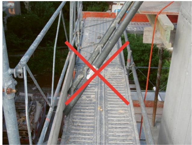
4 Cette échelle repose sur une surface instable. Si la plinthe cède, la chute est inévitable.
