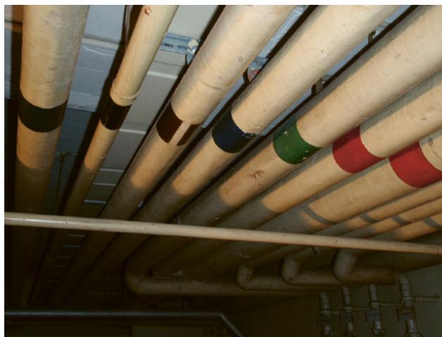
1 Isolation de tuyau composée de plâtre amianté.
