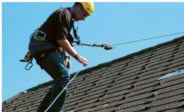
3 Le risque de chute de hauteur à travers ou depuis le toit existe aussi en cas d'inspection: un assurage dans les règles de l'art est indispensable en toute circonstance!
