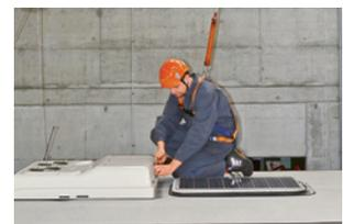
4 Travaux avec EPI antichute sur le toit d'un bus
