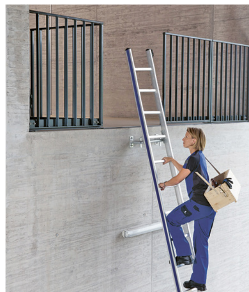
7 Come salire in condizioni di sicurezza: sguardo rivolto verso la scala, buone calzature, tenersi saldamente con due mani, trasporto del materiale nell'apposita cassetta
