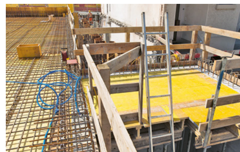
8 La scala supera di almeno 1 m il piano superiore; la sicurezza nel passaggio è garantita grazie alla presenza delle protezioni laterali
