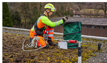
3 Protezione anticaduta con sistema di arresto caduta
