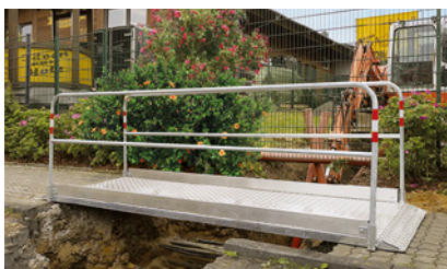
1 Ponte su uno scavo
