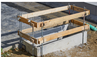
1 Pozzo luce messo in sicurezza con protezione laterale
