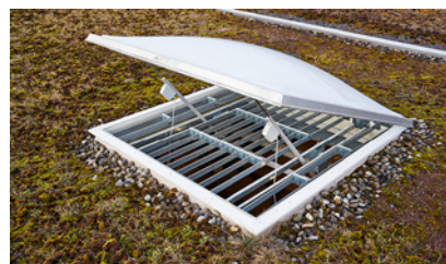
3 Lucernario messo in sicurezza con una griglia permanente posta all'interno
