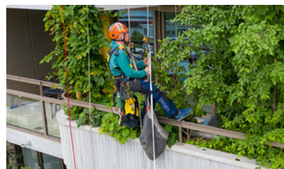
3 Lavori in sospensione a corde portanti
