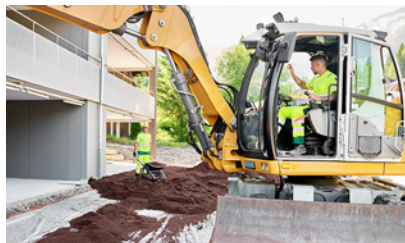
2 Lavoratore ben visibile nella zona di pericolo di una macchina edile
