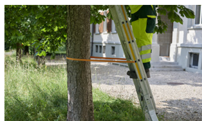
3 Scala messa in sicurezza
