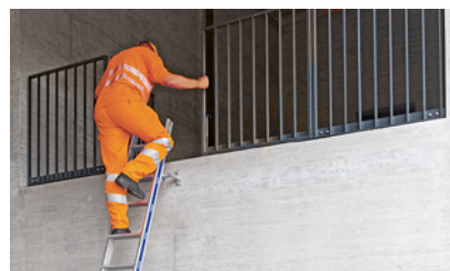
3 Dispositivo per tenersi, protezione laterale ed estremità superiore della scala messa in sicurezza
