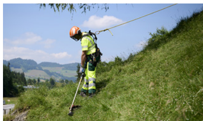
2 Lavori su terreni scoscesi
