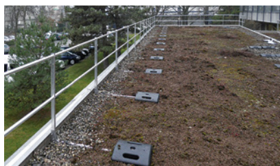
2 Bordo del tetto con protezione collettiva
