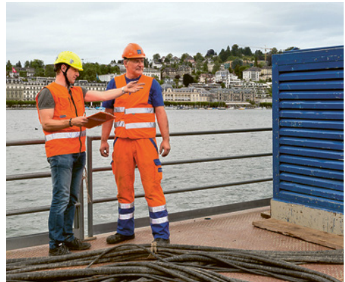
1 Das Arbeiten am, im oder über Wasser erfordert vertieftes Fachwissen und eine systematische Koordination der Sicherheitsmassnahmen.
