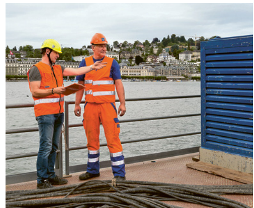
1 Das Arbeiten am, im oder über Wasser erfordert vertieftes Fachwissen und eine systematische Koordination der Sicherheitsmassnahmen.
