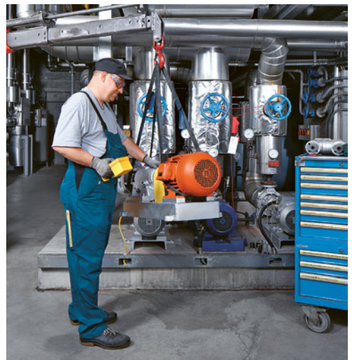
2 Der Instandhalter benützt die vorgegebenen Hilfsmittel, hier den Kran.
