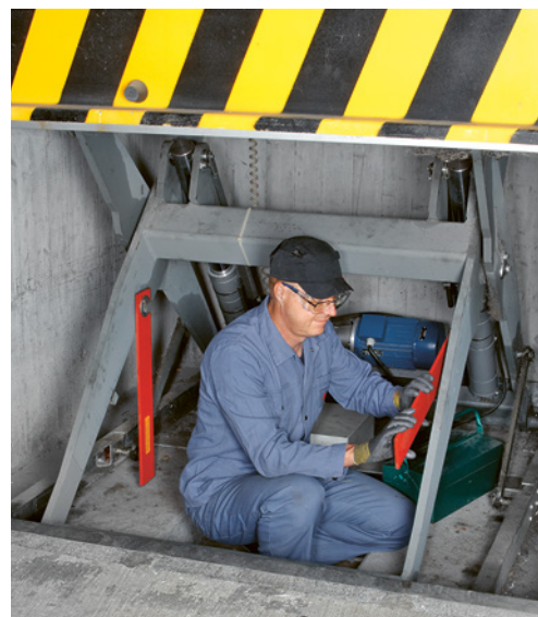
4 Die angehobene Hebebühne wird mit Stützen gesichert.
