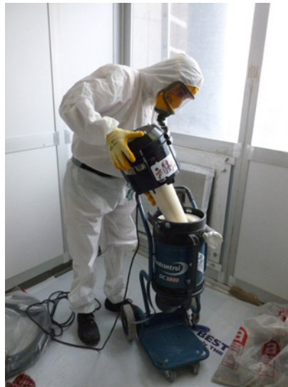
5 Entretien et contrôle périodique de l'appareil en zone confinée effectués par une entreprise spécialisée en désamiantage
