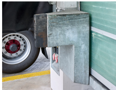
1 Achtung Einklemmgefahr! Mindestabstand zwischen Mauer und Lastwagenaufbau: 0,4 m
