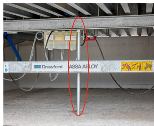
6 Die Wartungsstütze muss ohne Schwierigkeiten installiert werden können und mit der Rampe verbunden bleiben. Wartungsstützen müssen an jeder Rampe vorhanden sein.
