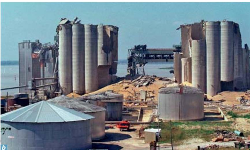
**Bild 1** Explosionsauswirkungen: **a)** Auswirkungen nach einer Gasexplosion in einem Kraftwerk. **b)** Nach einer Staubexplosion standen von 44 Silozellen einer Kornsilanlage nur noch wenige, jedoch schwer beschädigte Zellen
