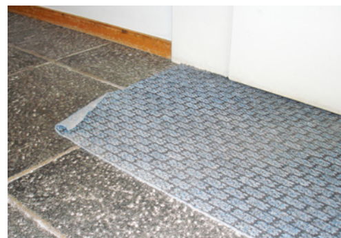
8 Auch kleine Stolperfallen müssen gemeldet und behoben werden.
