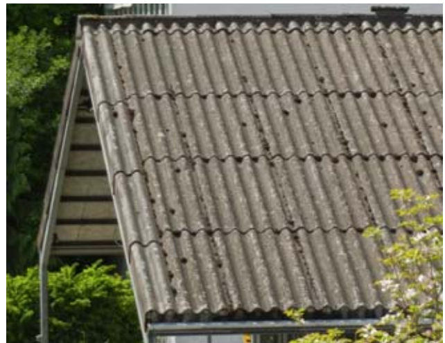
1 Lastre ondulate in fibrocemento contenente amianto.
