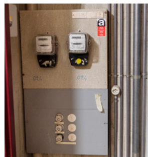
1 Asbesthaltige Schaltgerätekombination
