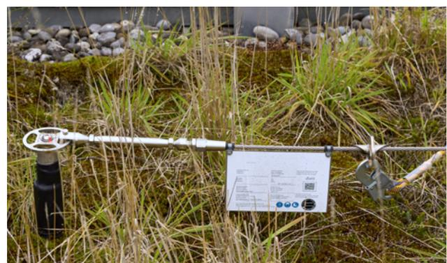
44 Permanente Anschlagseinrichtung mit Seilführung und Gleiter
