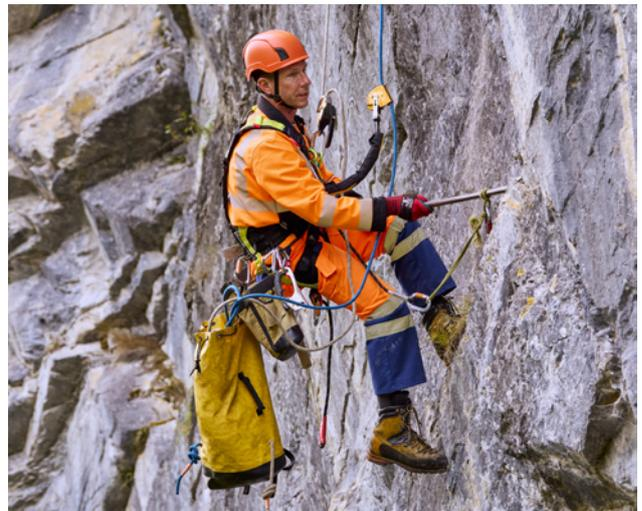
7 Arbeiten am hängenden Seil (SZP) mit Arbeits- und Sicherungssystem
