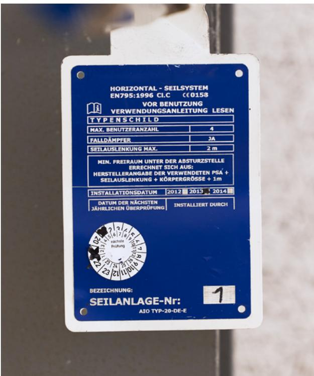
46 Typenschild einer permanenten Anschlageinrichtung mit Prüfplakette
