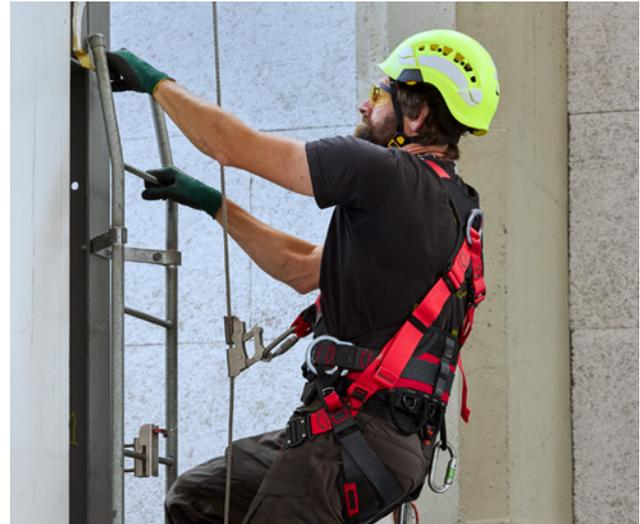
26 Mitlaufendes Auffanggerät einschliesslich beweglicher Führung aus Stahlseil (SN EN 353-2)
