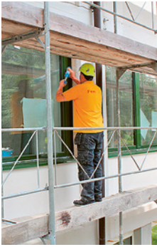
2 Fassadengerüst als Absturzsicherung
