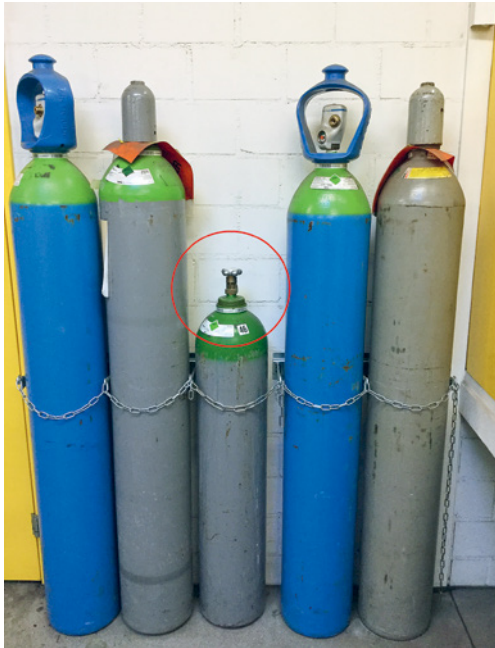
Figure 9 Bouteilles de gaz assurées contre les chutes avec des chaînes. Le capuchon de protection manque sur la bouteille du milieu.
