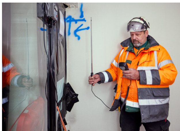
2 Verifica di una ventilazione efficace della zona di bonifica
