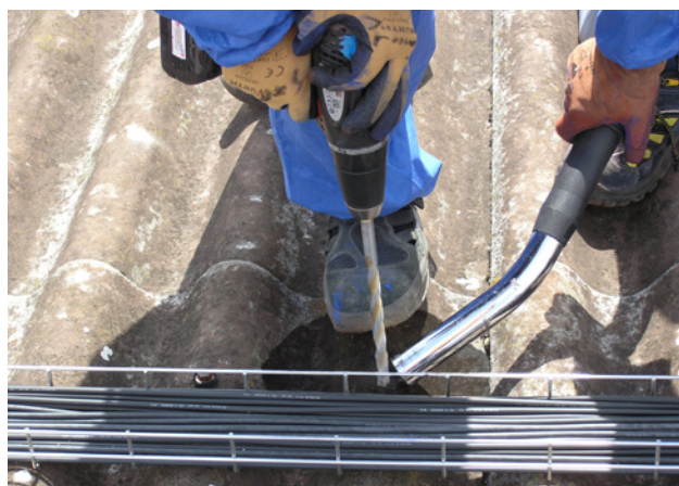
5 Percement en rotation lente, avec humidification et stricte aspiration à la source. Aspirer également sous la toiture.
