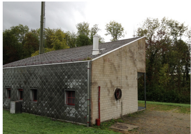
1 Nouvelle cheminée sur toiture en fibrociment amianté
