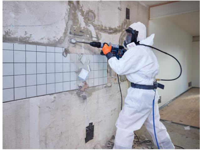
1 Mesures de protection conformément à la directive CFST 6503 «Amiante»
