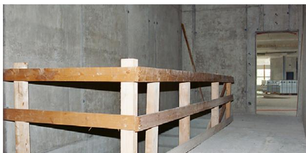
2 Garde-corps périphérique utilisé pour sécuriser une zone à risque de chute
