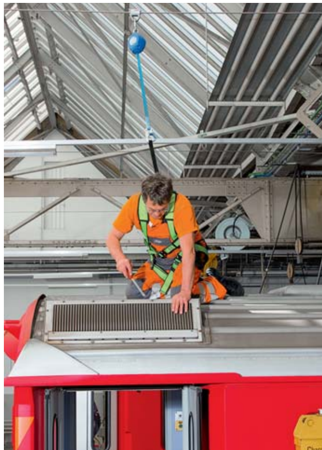
Toujours s'encorder pour les travaux en hauteur.
