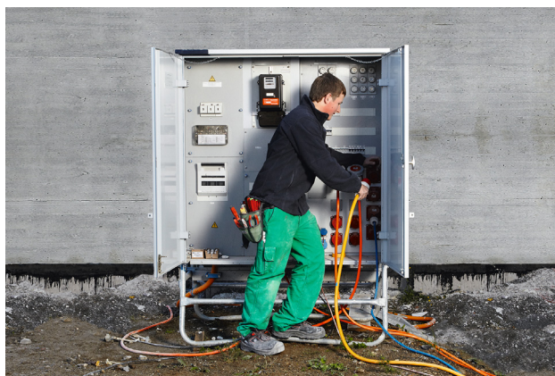
1 Elettricista installatore alle prese con un'installazione provvisoria
