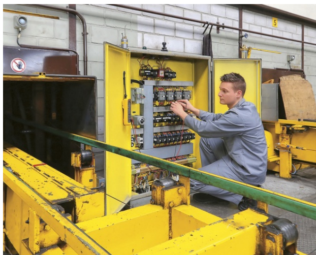
2 Ricerca guasti sul quadro elettrico di una macchina
