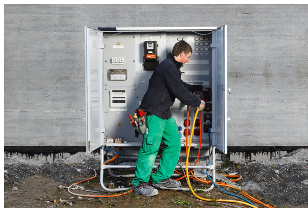
1 Elettricista installatore alle prese con un'installazione provvisoria
