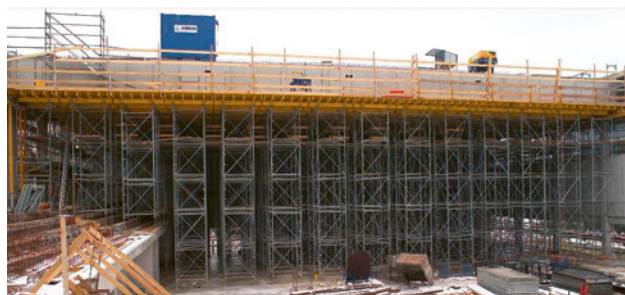
3 Système de coffrage moderne pour la réalisation de murs en béton de grande hauteur.
