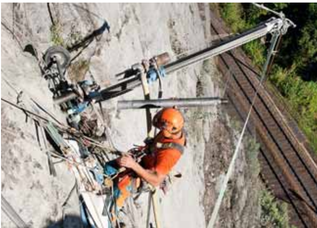
Bild 9 Einspannvorrichtungen mindern die Vibrationsbelastung durch Handmaschinen.
