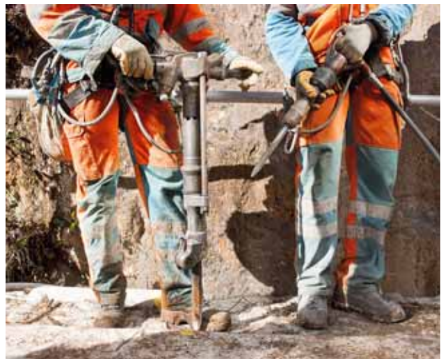
Bild 8 Keine zu leistungsstarken Geräte verwenden. Beispiel: Kein Abbauhammer für einfache Spitzarbeiten.
