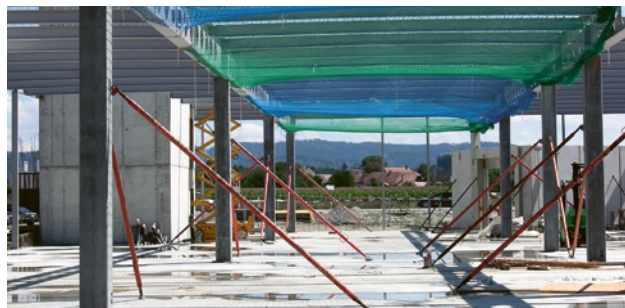
1 Le reti di sicurezza impediscono la caduta di persone all'interno della struttura in costruzione.
