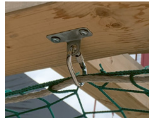
5 Sospensione con punto di fissaggio testato e moschettone
