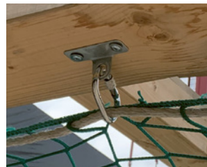
5 Sospensione con punto di fissaggio testato e moschettone
