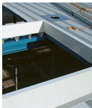
2 Rete di sicurezza immediatamente sotto le aperture del tetto
