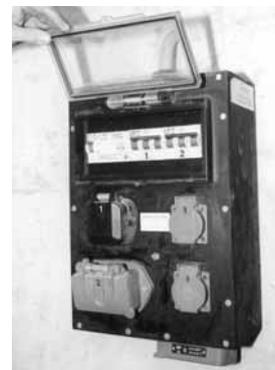
Bild 2: Stromverteiler mit Fehlerstromschutzschalter. Für Installationen ausserhalb von Gebäuden muss eine Fehlerstromschutzschaltung verwendet werden.
