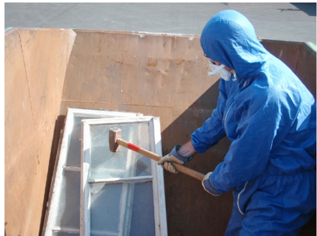
1 Séparation du vitrage au marteau.
