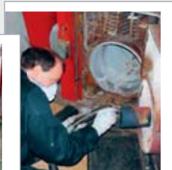
Asbest erkennen, beurteilen und richtig handeln Was Sie bei Kaminfegerarbeiten über Asbest wissen müssen
