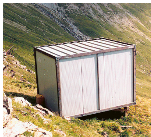
5 Questo container è protetto contro i fulmini e si trova in un luogo sicuro in prossimità del posto di lavoro.
