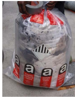
2 Abfälle aus schwachgebundenen Asbestmaterialien staubdicht in reissfestem Kunststoff sack verpackt.
