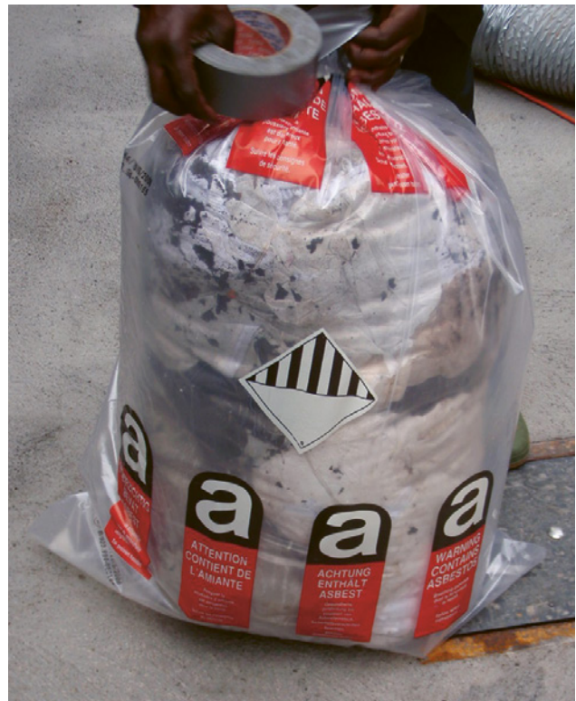
2 Asbesthaltige Abfälle staubdicht, in reissfestem Kunstsacksack verpackt.
