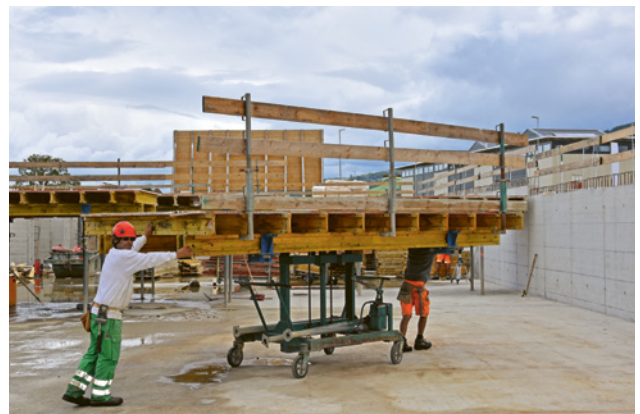
6 Deckenschalungselement mit vormontiertem Kollektivschutz (dreiteiliger Seitenschutz) wird versetzt.
