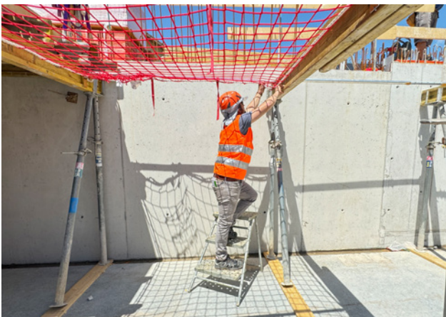
4 Einhängen von Auffangnetzen mit Hilfe eines Tritts.
