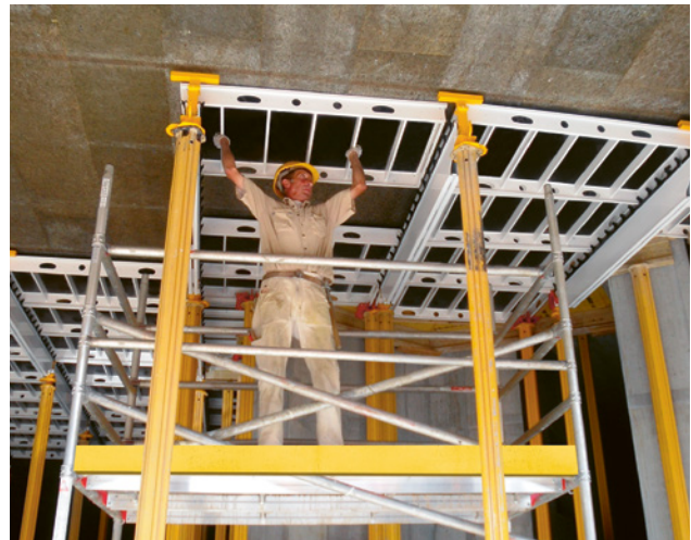
1 Zeitgemässes System: Schalen und Ausschalen von unten.
