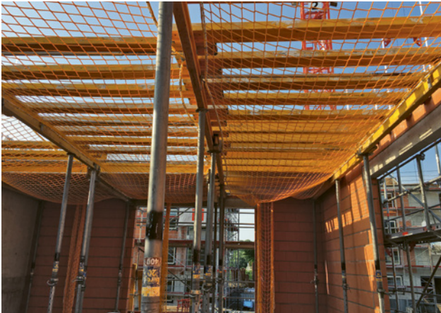
3 Konventionelles Schalen mit kollektiver und nachweislich geprüfter Sicherheitseinrichtung (Auffangnetze).
