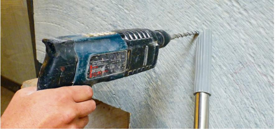
Beim Bohren in Serpentinitt Quellenabsaugung einsetzen.
