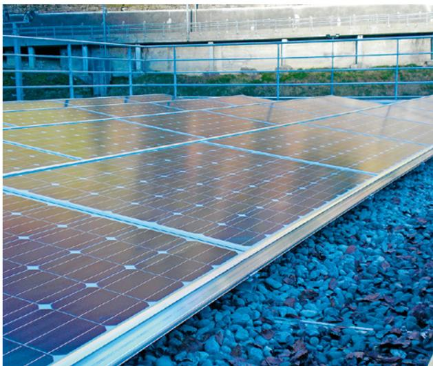
5 Solaranlage auf Flachdach mit umlaufendem, permanentem Geländer
