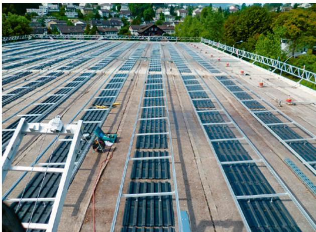
2 Montage einer Solaranlage mit umlaufendem temporärem Seitenschutz am Dachrand
