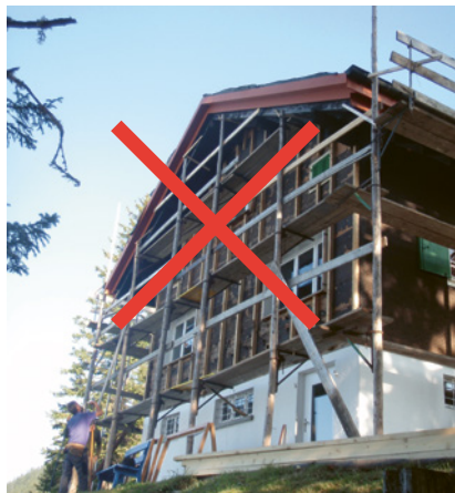
5-6-7 Ponteggi di facciata inadeguati e non consentiti
