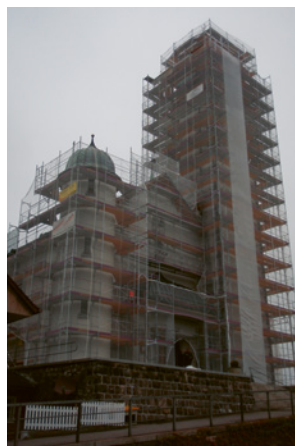
2 Ponteggio di facciata a norma
