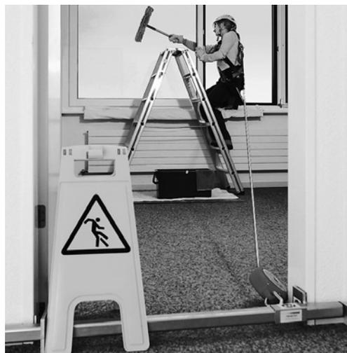
7 Nettoyage des fenêtres. La personne est assurée au moyen d'un antichute à rappel automatique en position horizontale. Le dispositif est fixé à une traverse ancrée dans le châssis de la porte.
