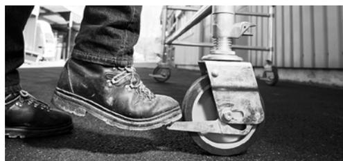
4 Blocage des roues avant de monter sur un échafaudage roulant.
