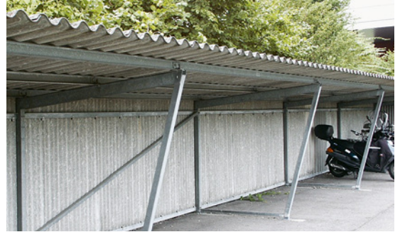
Façades, toits en fibrociment
