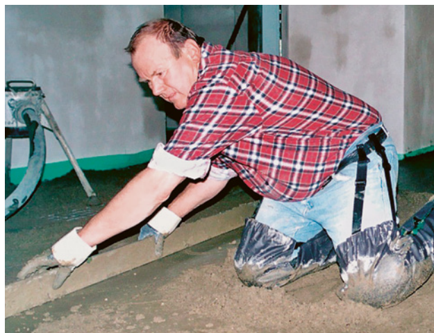
15 Mit «Abziehhosen» oder wasserdichten Knieregionen werden Verätzungen durch Zement verhindert.
